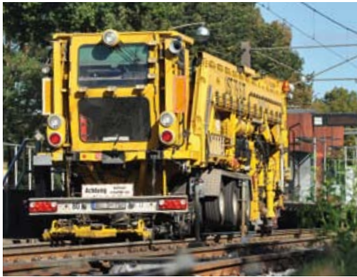
Mit gelifteten Lkw-Achsen arbeitet die zweigegefahrbare Universal-Stopfmaschine Plasser & Theurer UST 79 S im Stadtbahngeleis.
