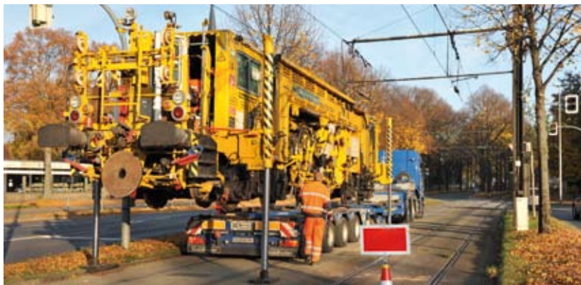
Mit vier Hydraulikstempeln stemmt sich die selbstverladende Stopmaschine Plasser & Theurer 08-275 ZW beim Wechsel zwischen Gleis und Transport-Tieflader in die Höhe.
