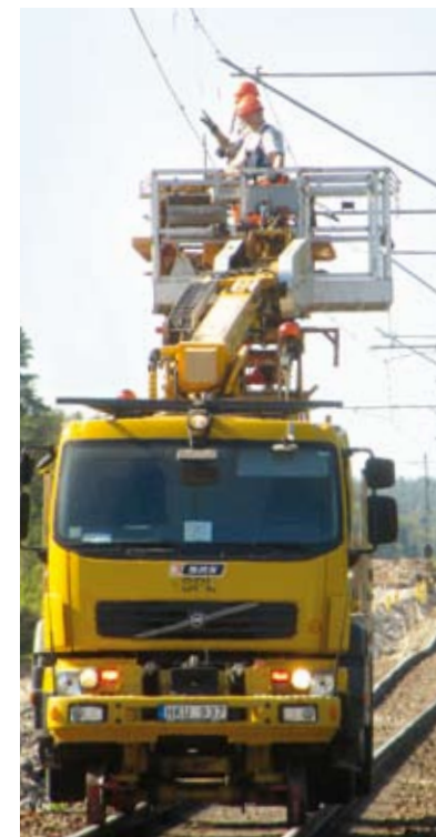
SRS Arbeitsbühne bei einem Einsatz in Schweden.
