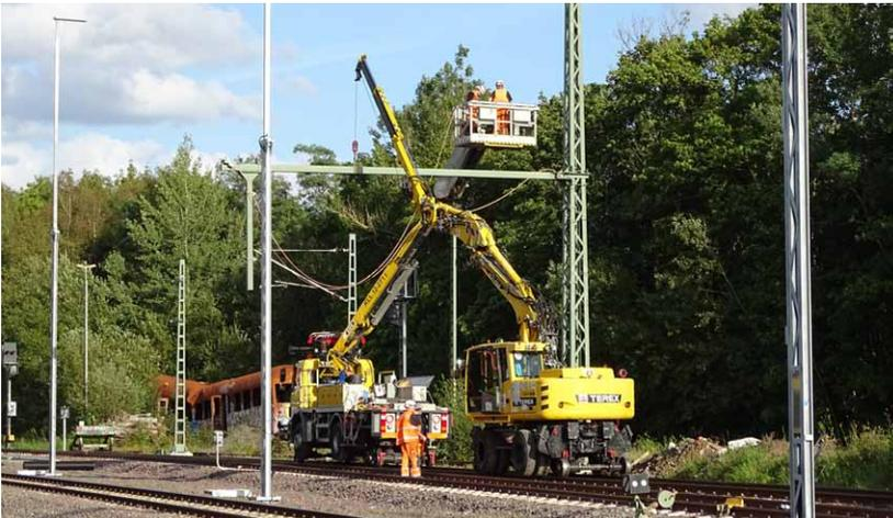
*Einsatz der BSB beim Aufstellen von Masten und der Montage von Auslegern mittels Zweigegebagger und eigener Armverlängerung.*
