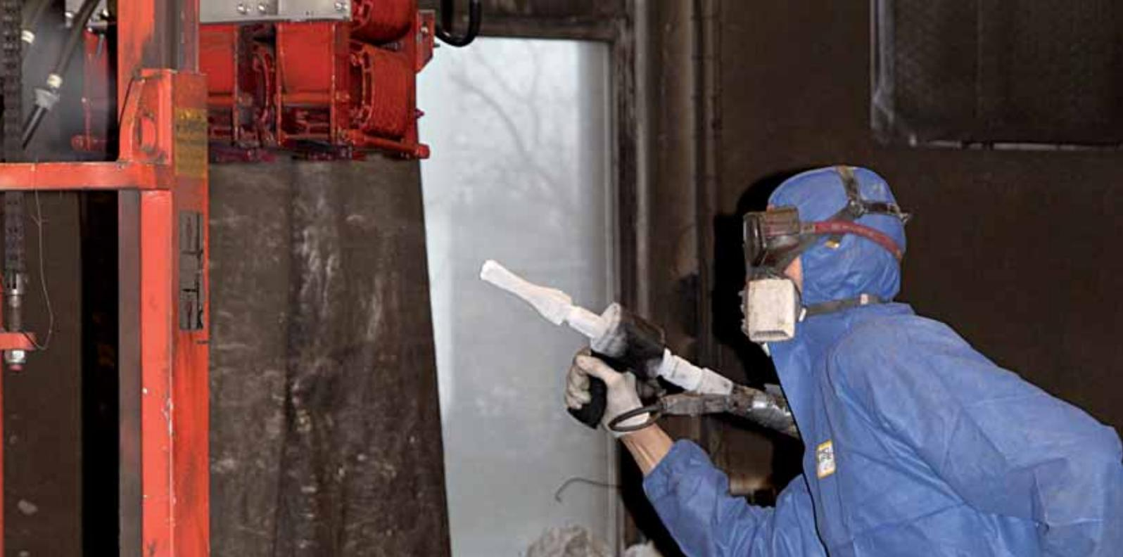
*Trockeneisstrahlen ist oberflächenschonend und eignet sich insbesondere für elektrische Geräte und Anlagen.*
