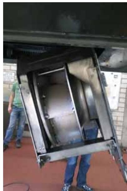
Auch größere Teile wie Rotations-Wärmetauscher werden erreicht.
