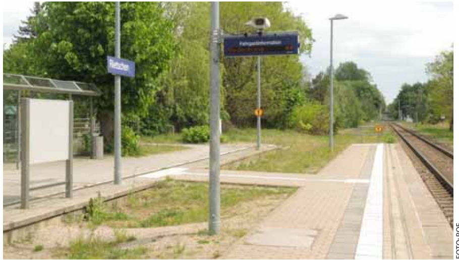
Der Bahnhof Rietschen zwischen Cottbus und Görlitz war schon einmal zweigleisig, wie dieses Bild erkennen lässt. Jetzt soll er es zur Strukturstärkung der Lausitz wieder werden. FOTO: ROE
